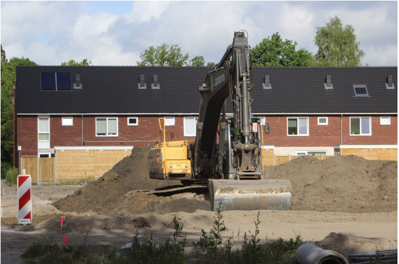
Het aanbrengen van een zandige bovenlaag bij de aanleg en inrichting van een nieuwe woonwijk (Foto: Martin Soesbergen)
